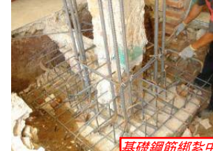
基礎鋼筋綁紮中
