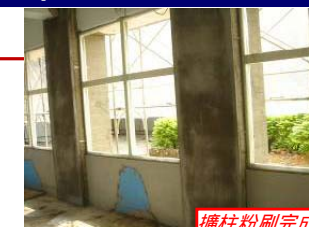
擴柱粉刷完成
