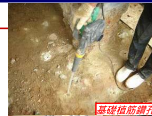
基礎植筋鑽孔
