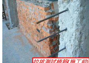
拉拔測試植筋(施工前)
