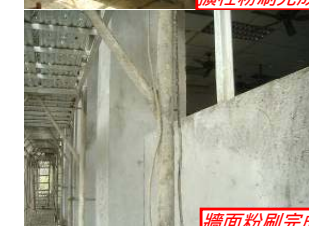
牆面粉刷完成
