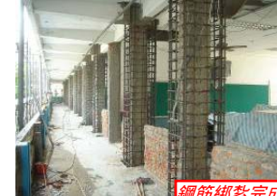
鋼筋綁紮完成
