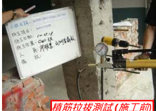
植筋拉拔測試 (施工前)
