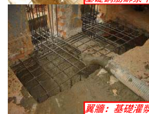
基礎鋼筋綁紮中
