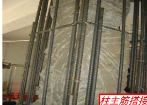
柱主筋搭接
