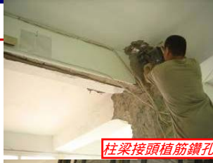
柱植筋鑽孔
