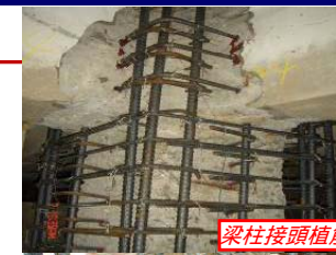
梁柱接頭植筋鑽孔
