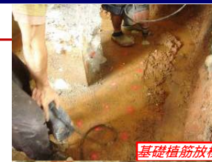
基礎植筋放樣
