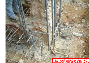
基礎鋼筋綁紮中
