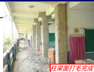
柱梁面打毛完成
