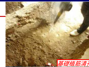
基礎植筋清孔
