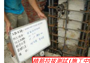
植筋拉拔測試 (施工中)
