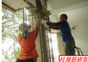
柱箍筋綁紮
